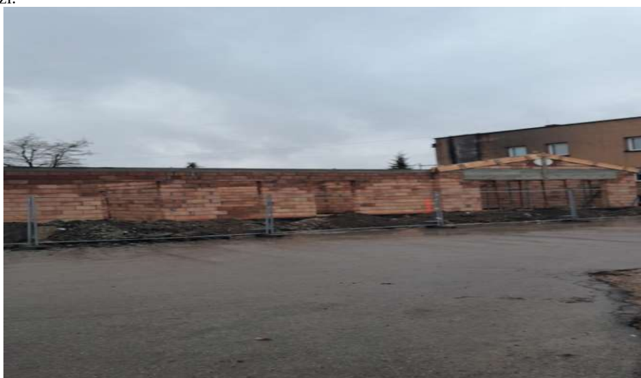
Fot. 2023r. .Rozpoczęcie rozbudowy Ośrodka Zdrowia w Książu Wielkim dla potrzeb rehabilitacji.
